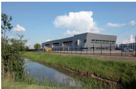
ITB2 Datacenter Ecofactorij Apeldoorn
